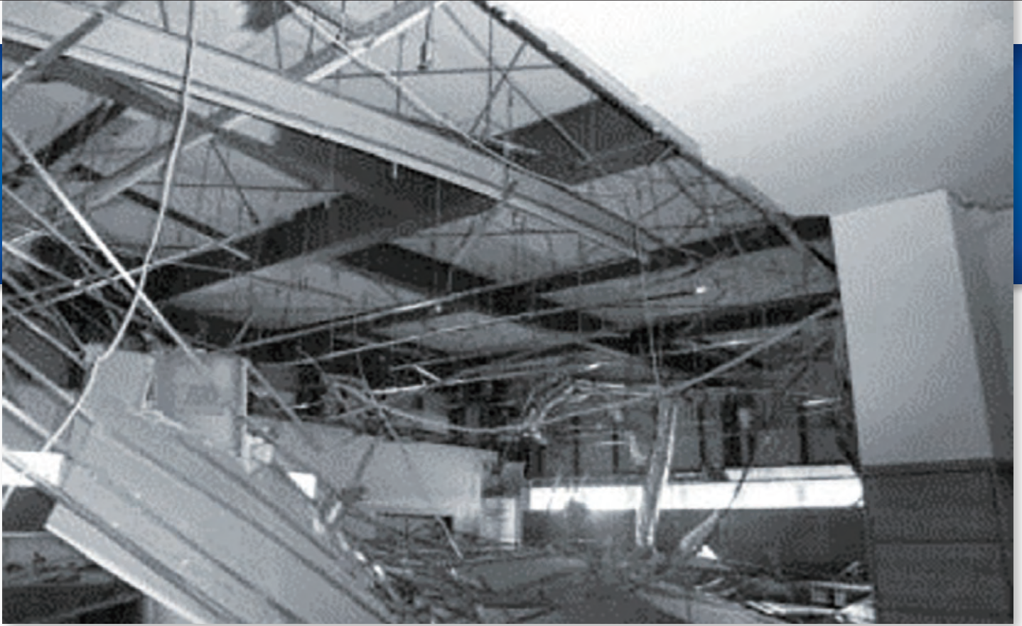
■ 東日本大震災での天井脱落例 [当社調査写真]
